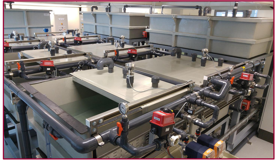
The Water Distribution (WADI) testbed
